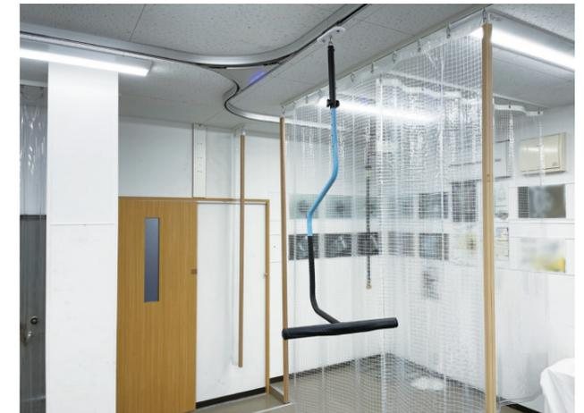
●カーブレールや分岐レールを繋ぎ合わせることで施設内での移動を可能にします。
